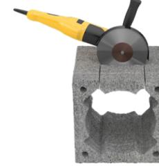
Mit einem Winkelschleifer schneiden Sie jetzt die davor angezeichneten Öffnungen in den Leichtbeton Mantelsteinen aus.
