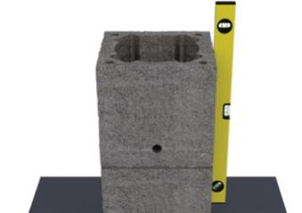
Im nächsten Schritt Stellen Sie den Leichtbeton Mantelsteinen mit der Öffnung für den Schlauch auf, und richten diesen aus.
