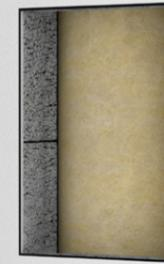
Die Öffnung ist freigelegt, die Dämmung aus Mineralwolle wird sichtbar.
