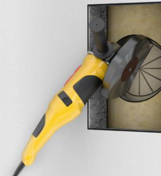
Das Kaminrohr mit dem Trennschleifer einschneiden oder fachgerecht anbohren. Keine Schlagbohrmaschine verwenden!
