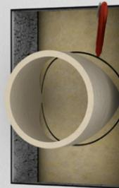
Mit dem Sattelstück als Maß an der Dämmung den Ausschnitt anzeichnen.
