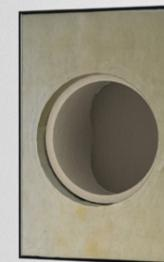
Nach dem Aushärten (1 - 2 Tage) Verspannung entfernen und Öffnung im Mantelstein mit der Frontplatte verschließen.
