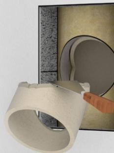
Das Sattelstück an dem ausgeschnittenen Rauchrohranschluss anpassen.
