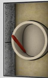
Dämmung ausschneiden und die lichte Weite vom Rauchrohranschluss markieren.
