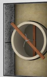
Mit Säurekitt bzw. Spezialkleber Sattelstück am Rauchrohr ansetzen und fixieren.
