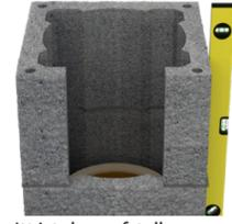
Der nächste Schritt ist das Aufstellen von dem Leichtbeton Mantelsteinen mit der zuvor vorbereiteten Öffnung für die Putztüröffnung, diese muss ebenfalls ausgerichtet werden.
